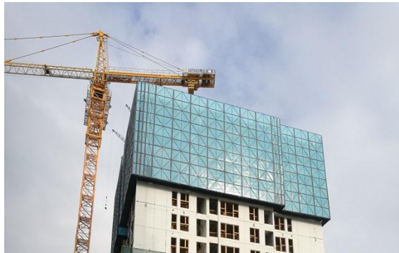
工具式脚手架
