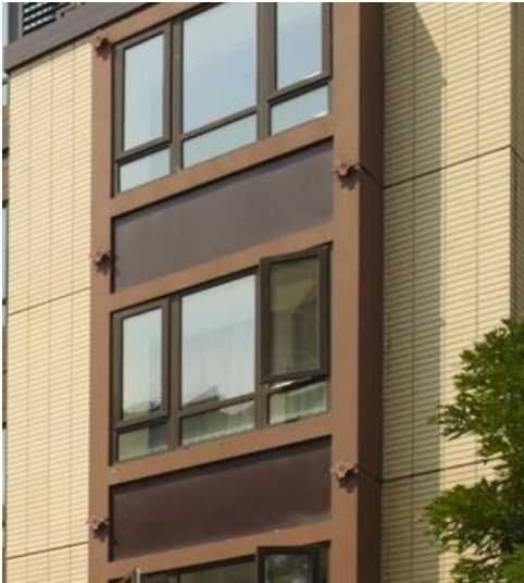
预制墙瓷砖反打
