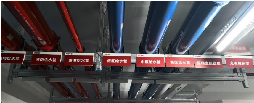
采用主体结构和管线分离
