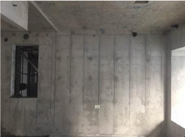
免抹灰铝模墙体
