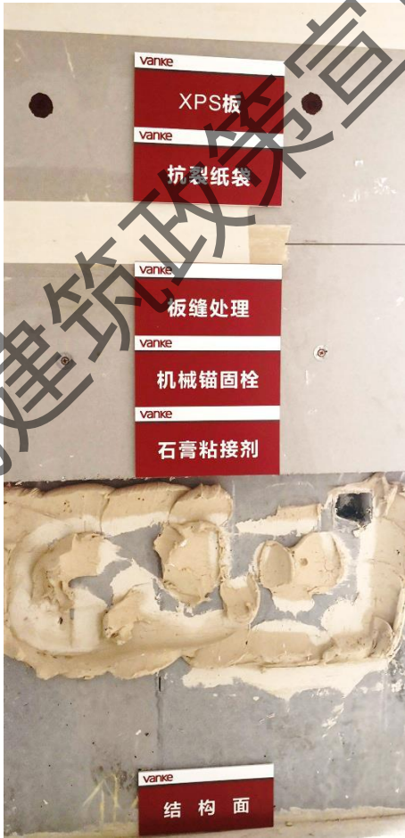
采用板材类保温材料、干式工法施工
