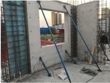
预制剪力墙、柱
