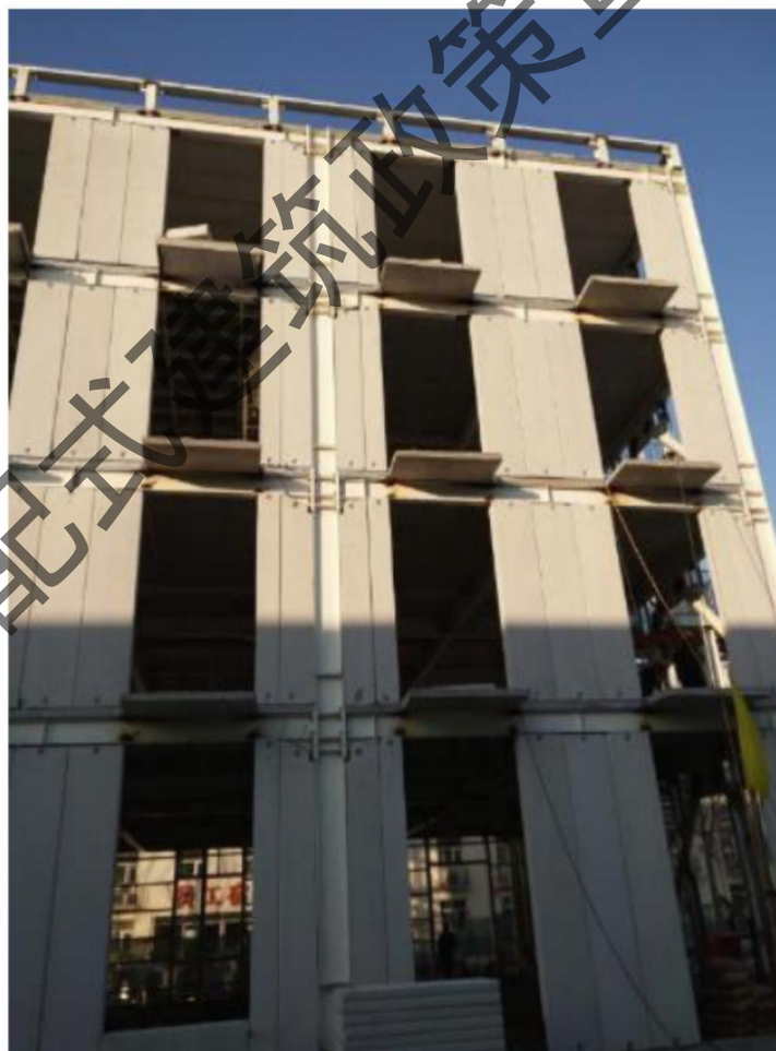
钢结构外墙施工示例（内嵌式）
