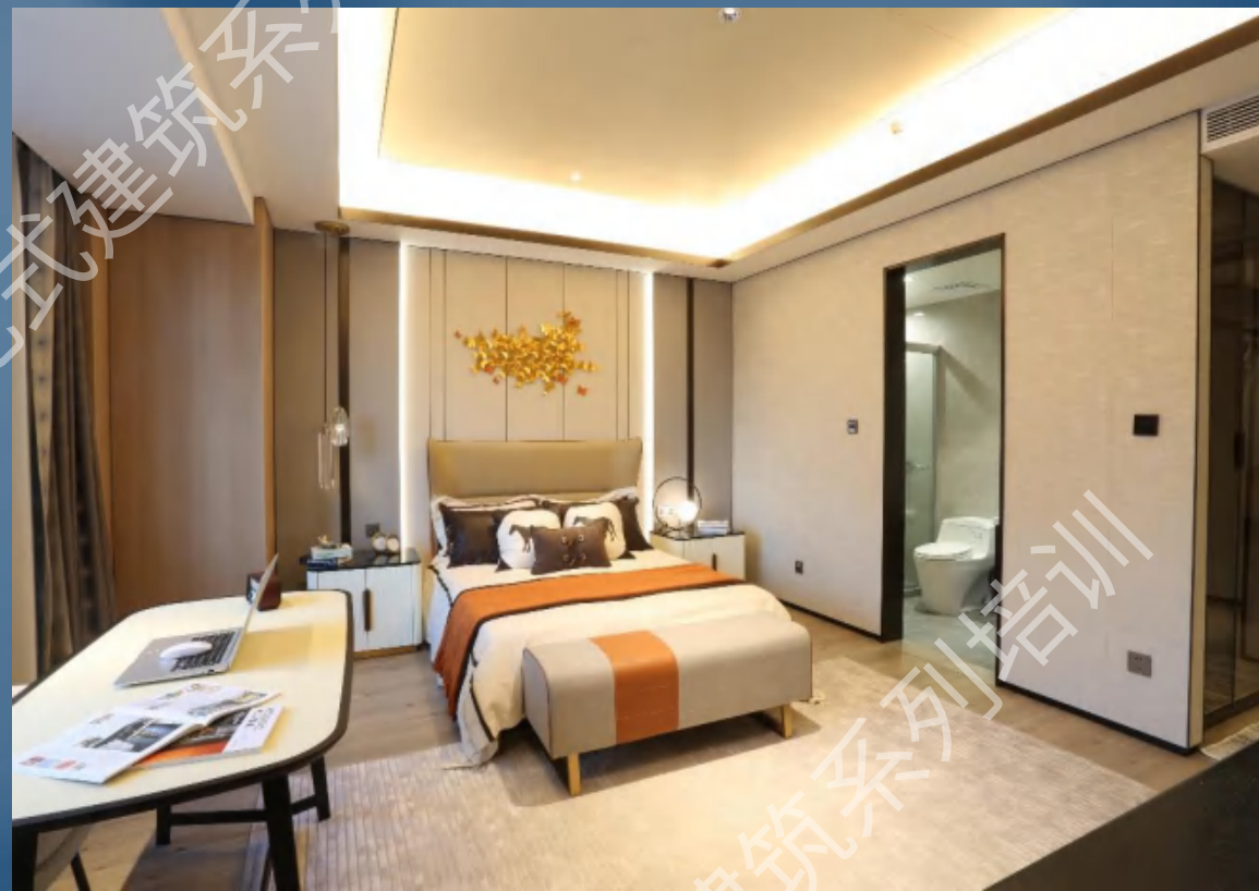
石膏板边吊+集成天花板
